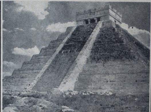
Vista parcial de "El Castillo", mostrando las obras de restauración llevadas a cabo por la institución "Carnegie".
